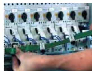
Надежная установка и электромонтаж
